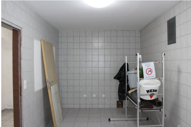
Raum 1 in Richtung Norden
