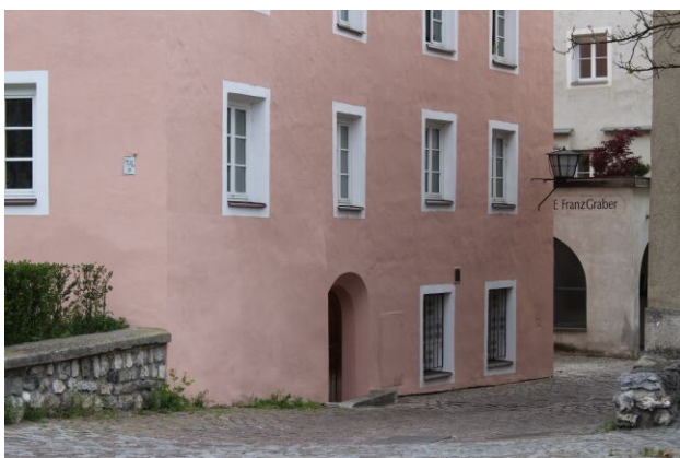
Ansicht Südfassade und Zufahrtsstraße zu den Frestellplätzen
